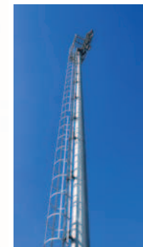
Stâlp pentru proiectoare cu scară de siguranță Прожекторная мачта с лестницей с ограждением
